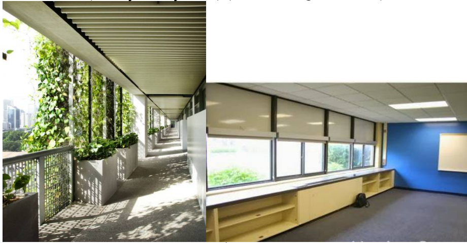
شكل رقم (24): استخدام دواليب الحائط لزيادة سمك الحائط الأكثر عرضة للحرارة وتحسين الاحساس بالراحة الحرارية داخل الفصول التعليمية (https://kindercraze.com) استخدام أحواض الزهور لزيادة سمك الحوائط وتقليل انتقال الحرارة للداخل. الممر الخاص بمدرسة الفنون بسنغافورة (www.arup.com)
