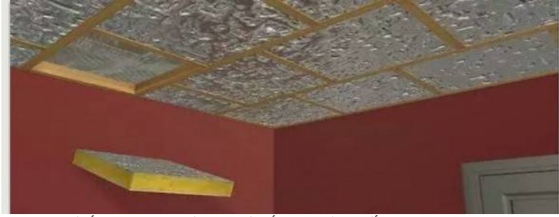
شكل رقم (18): تركيب سقف مستعار فيه قطع من الألياف الزجاجية أو الصوف الزجاجي وهو الأعلى في امتصاص الصوت بين جميع المواد (www.engineering4trade.com)
